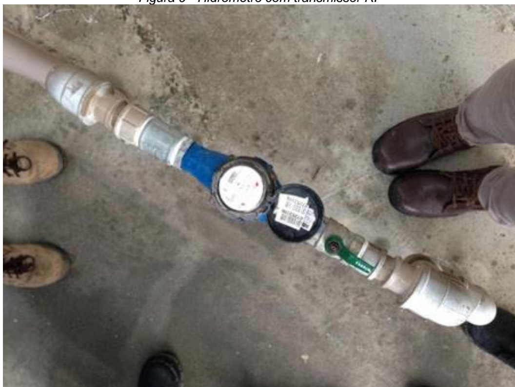
Figura 9 - Hidrômetro com transmissor RF
